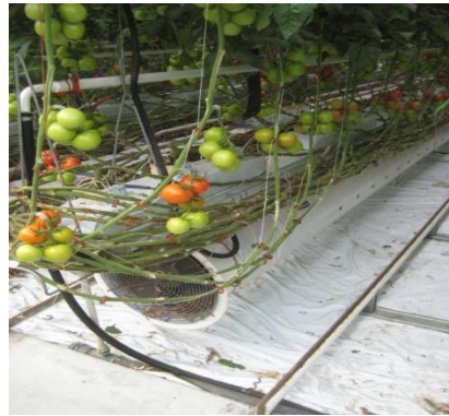
Slika 32. Ventilacija unutar staklenika (Fotografija: Šarlija K., 2016.)
