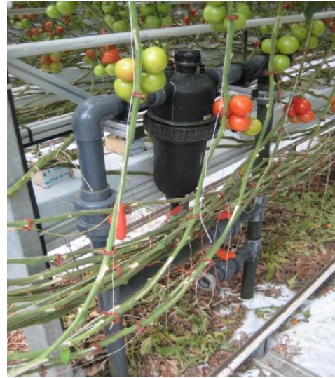
Slika 26. Jedinice za navodnjavanje unutar staklenika ( Fotografija: Šarlija K., 2016.)
