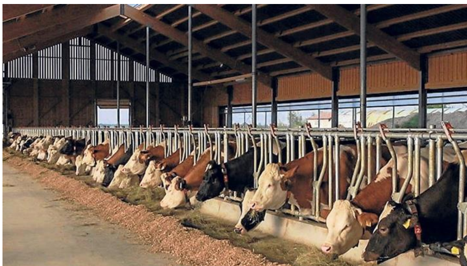
Slika 7. Primjer objekta sa dobro postavljenim otvorima za strujanje zraka (Izvor: www.poslovni-dnevnik.com )
