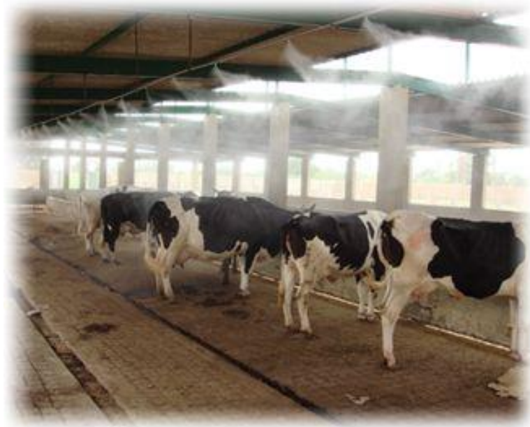
Slika 11. Prikaz hlađenja staje orošavanjem (Izvor: www.savjetodavna.hr )
