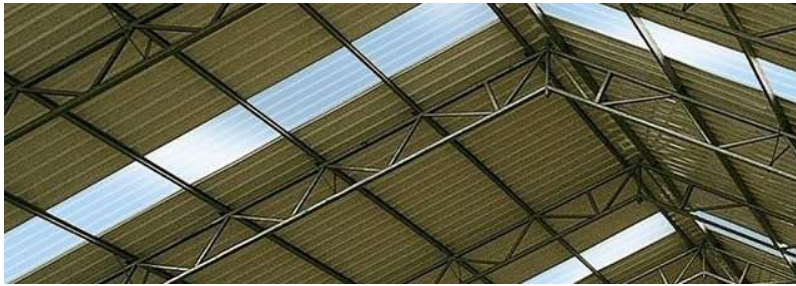
Slika 3. Površina krova od prozirnog materijala ( http://builddailys.com/hr/pages/1639309 )
