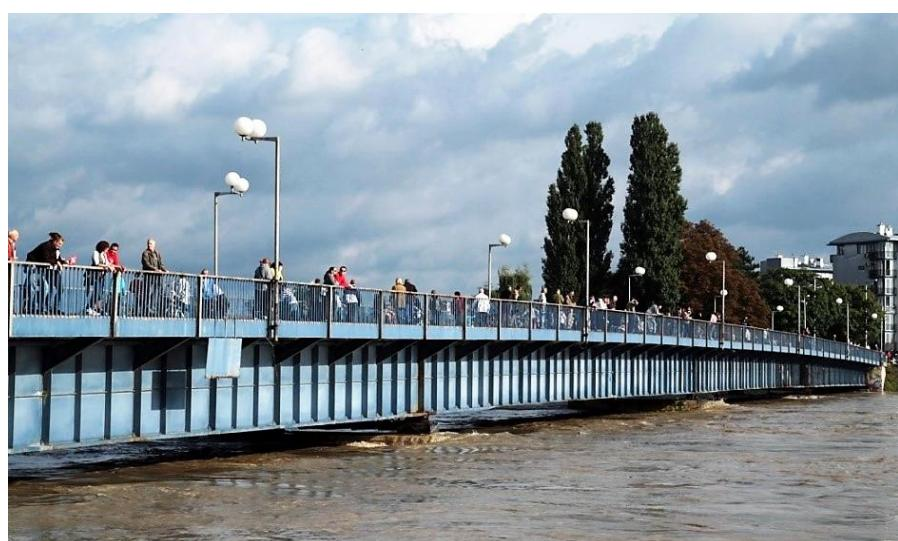
Slika 1. Savski most u Zagrebu izgrađen 1938.g. zavarivanjem
