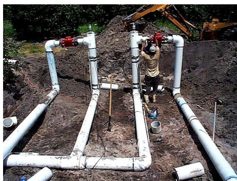
Slika 27. Ugradnja PVC cijevi za navodnjavanje plantaže agruma
