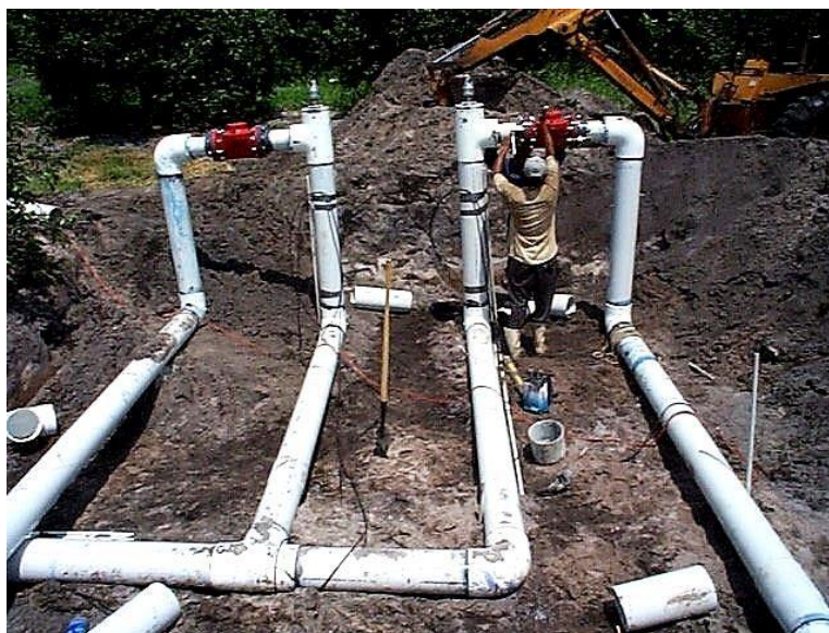
Slika 27. Ugradnja PVC cijevi za navodnjavanje plantaže agruma
