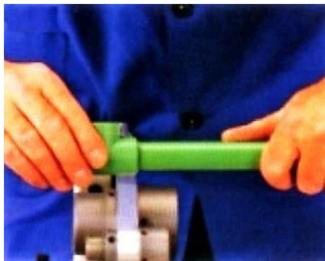
Slika 24. Zavarivanje PP-R cijevi: Utiskivanje cijevi u koljeno
