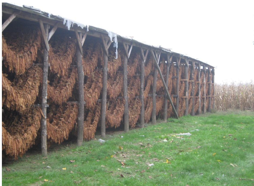
Slika 5. Sušara s drvenom konstrukcijom u tri etaže
