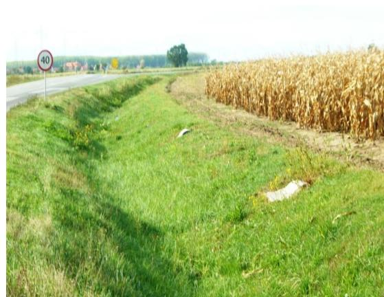
Slika 16. Kanal za odvodnju za izvodima lizimetarskih posuda
