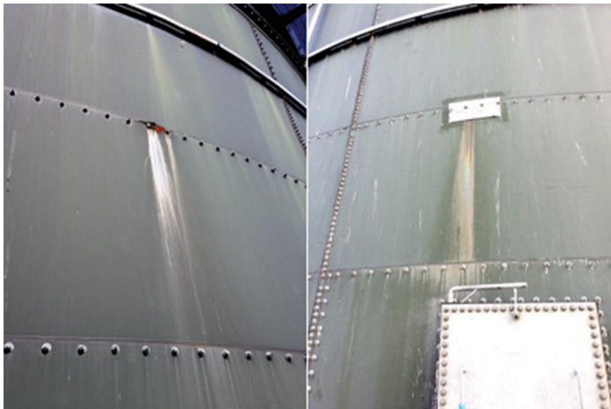
Slika 30. Oštećenje i zakrpa na čeličnom digestoru
