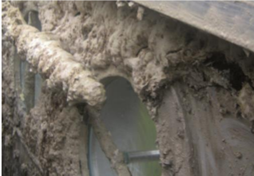
Slika 33. Nakupljanje sumpora unutar biodigestra, kao rezultat desulfurizacije
