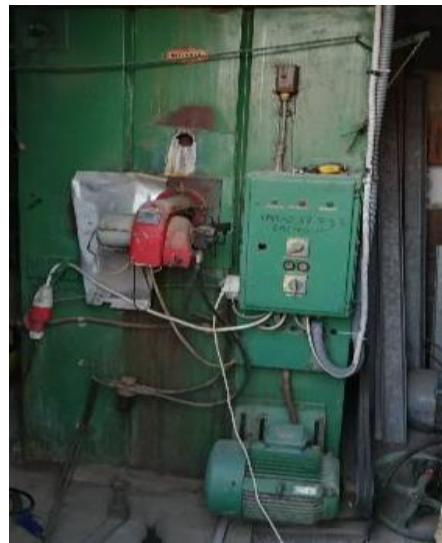
Slika 20. Pogon sušare, plamenik i elektromotor proizvođača *Končar*
