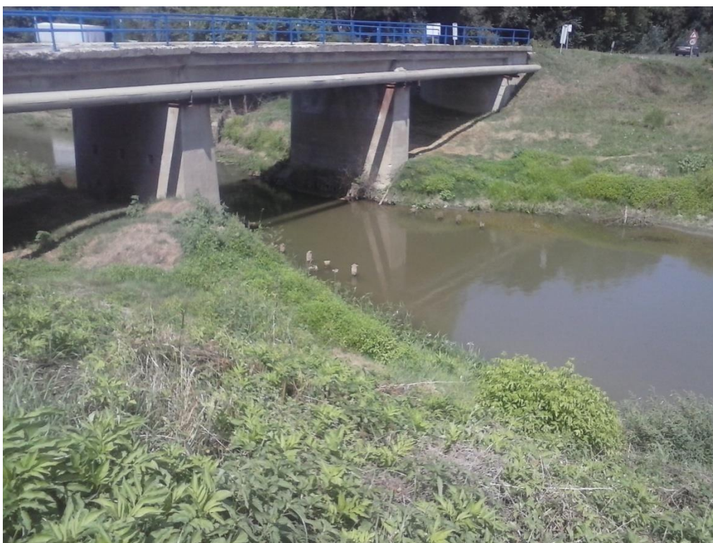
Slika 30. Most na Vučici zapadno od Ladimirevaca (foto F. Vrbanić)
