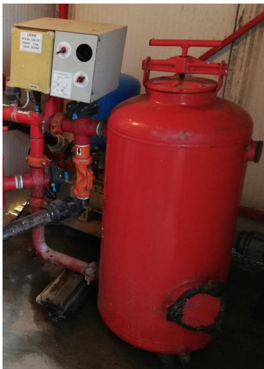
Slika 7: Prvi filter za pročišćivanje vode od čvrstih čestica izvor: Mirna Škoro (2019.)
