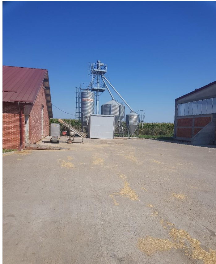
Slika 10. Cikloni za spremanje koncentriranih krmnih smjesa
