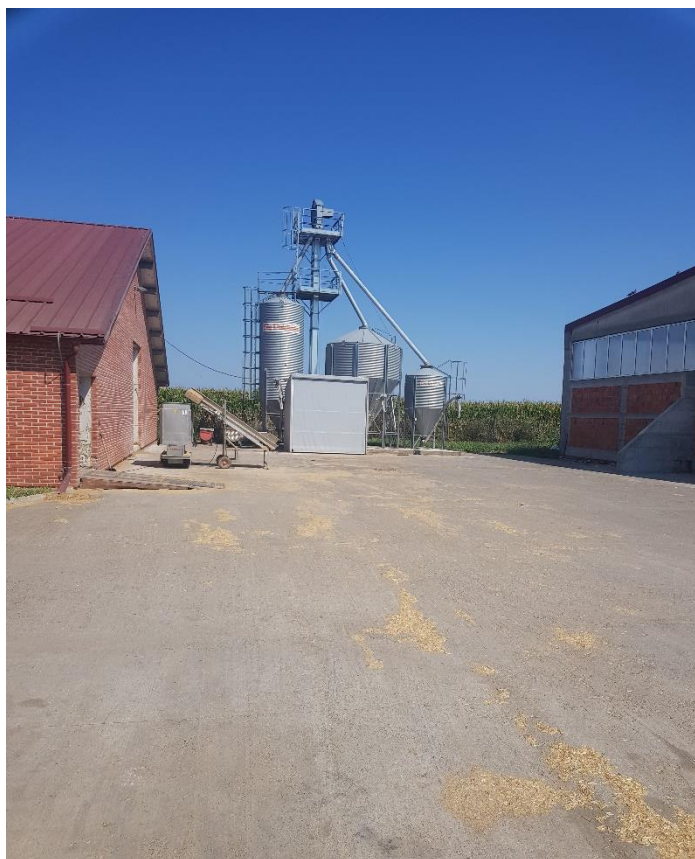
Slika 10. Cikloni za spremanje koncentriranih krmnih smjesa
