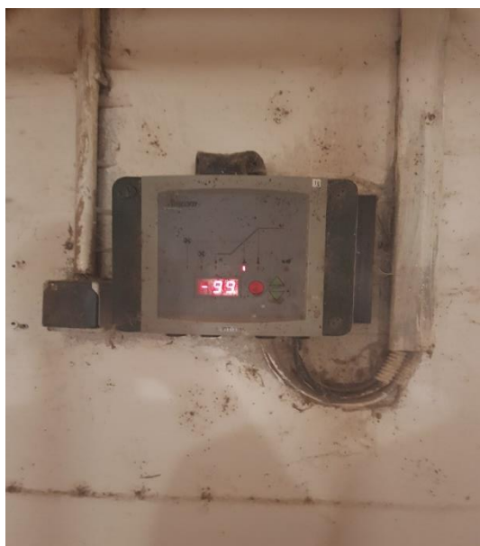
Slika 3. Upravljačka jedinica za ventilaciju proizvodnog objekta
