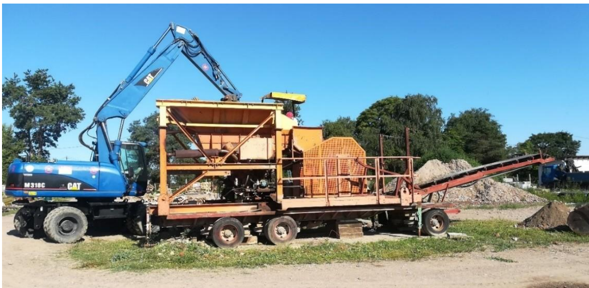
Slika 5. Drobilica građevinskog materijala (Izvor: Vlastita fotografija)
