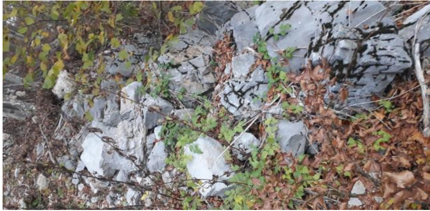
Slika 11. Slabo obrasle stijene (Foto: T. Drenjančević)
