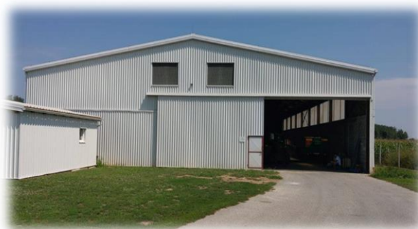
Slika 3. Skladišni silos OPG-a Dragan Čolaković
