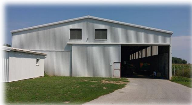
Slika 3. Skladišni silos OPG-a Dragan Čolaković
