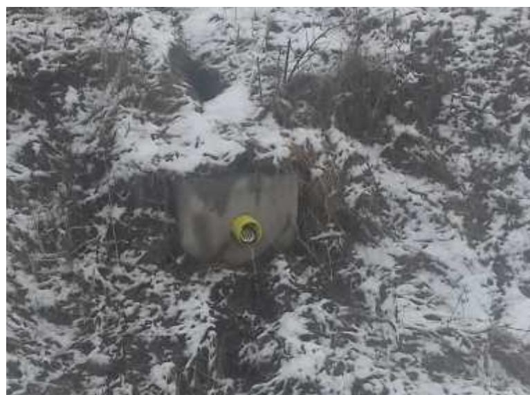
Slika 10. Prikaz istjecanja vode cijevnom drenažom
