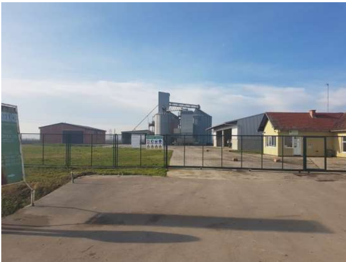
Slika 1. Organizacijska jedinica silos s ekonomskim dvorištem i tehničko-tehnološkim postrojenjima (Izvor: Lukačević, M.)
