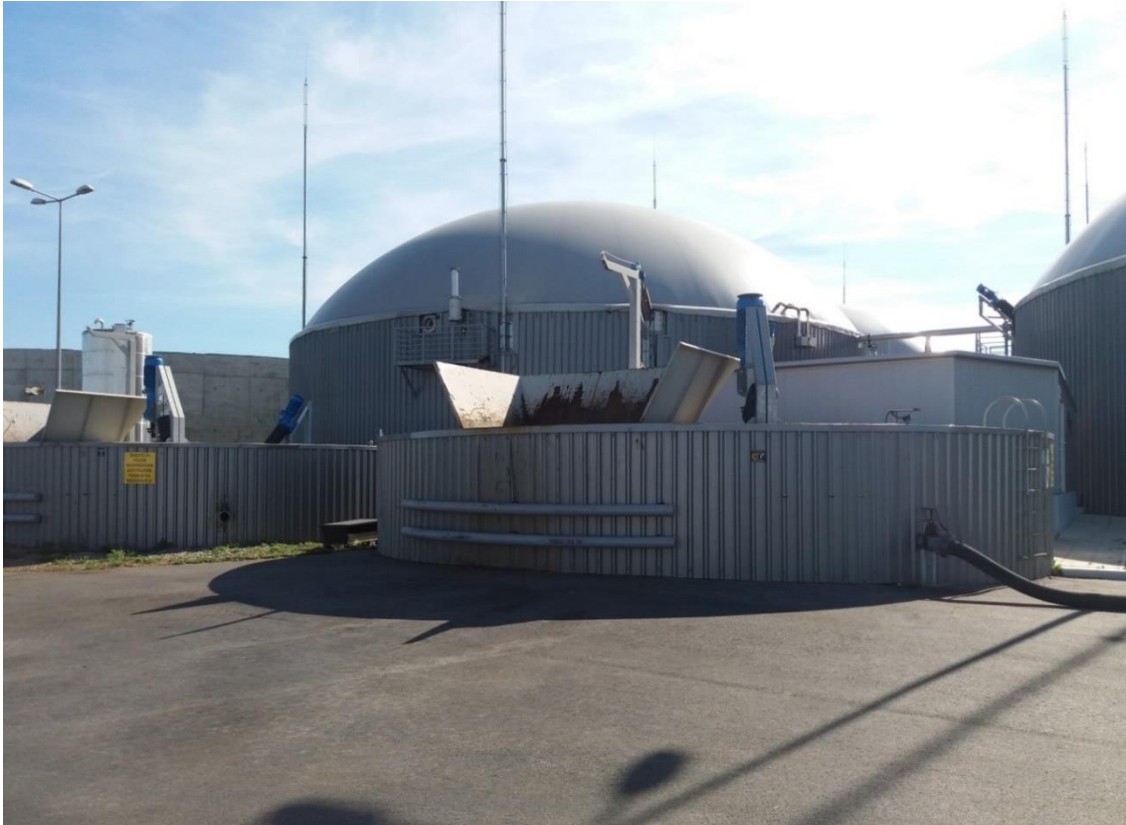
Slika 8. Mješače jame za doziranje krute sirovine
