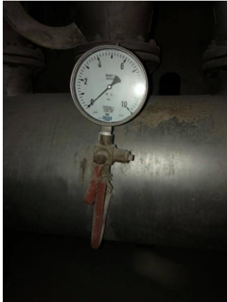
Slika 34. Manometar (Izvor: slikao autor)
