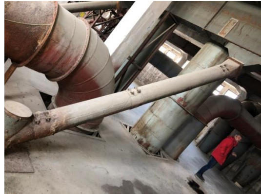
Slika 27. Cijev koja spaja transporter i sušaru (Izvor: slikao autor)
