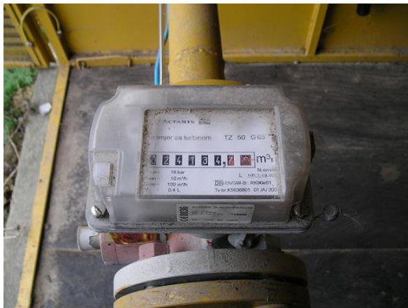
Slika 19. Mjerenje potrošnje plina plinskom turbinom (vlastita fotografija)
