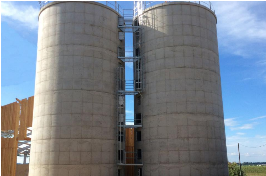
Slika 7. Vertikalni silosi (silo tornjevi)
