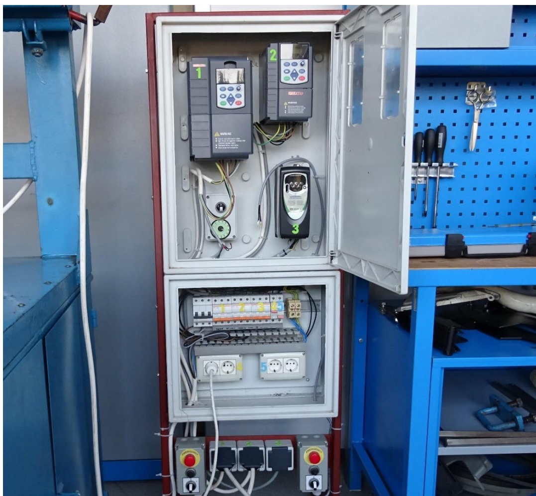
Slika 2. Statički frekventni regulator
