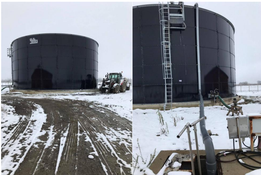
Slika 14. Bioplinsko postrojenje na poljodjelskom obrtu Srijem u Iloku
