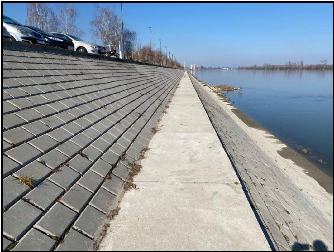
Slika 3. Obaloutvrda uz šetnicu u Vukovaru – novija gradnja
