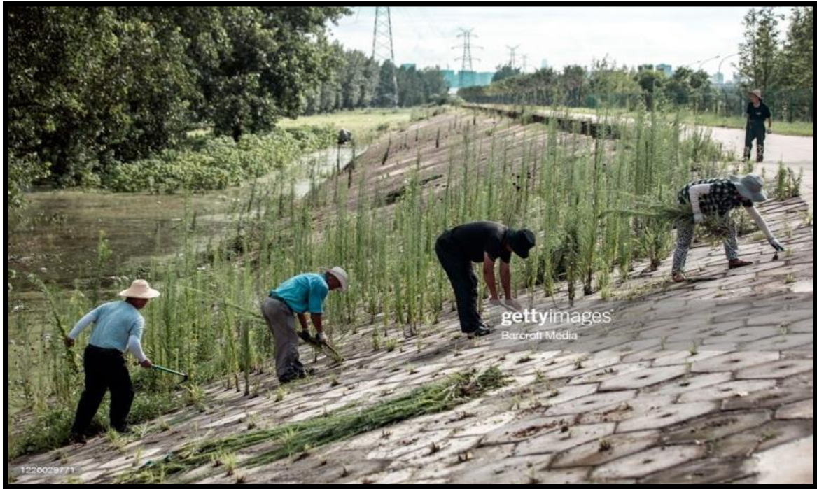
Slika 1. čišćenje zaraslih obalo-utvrda od korova
