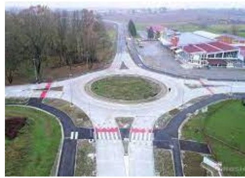
Sl. 26) Izvedeno stanje kružnog toka u Ulici Petra Krešimira IV u Našicama
