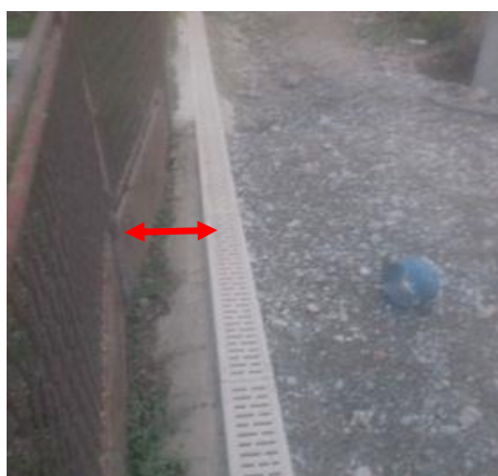
Sl.10) Spoj zatvorene kanalice i ograde, kolnog ulaza u dvorište. (Izvor: Autor, 2020.)
