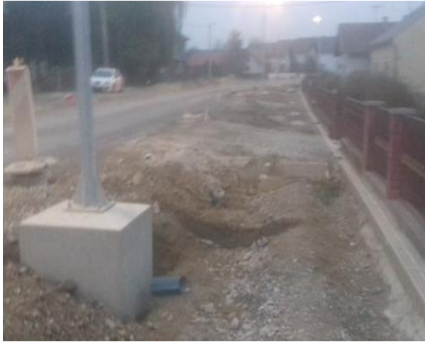
Slika 6) Betonska podnožja rasvjetnih tijela (Izvor: Autor, 2020.)
