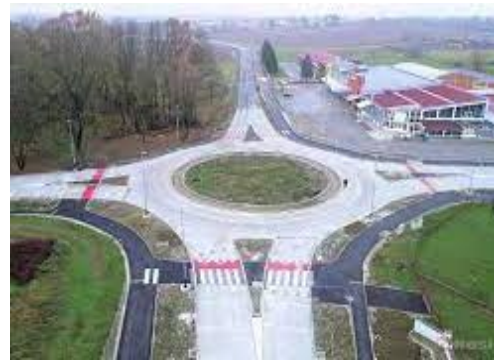
Sl. 26) Izvedeno stanje kružnog toka u Ulici Petra Krešimira IV u Našicama (Izvor:
