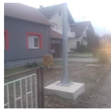
17) Kuća sa slike 16 nakon uklanjanja stabala i postavljanja rasvjete (Izvor: Autor, 2021.)
