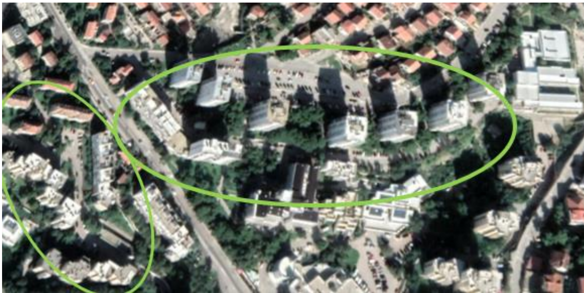
Slika 16. Izgrađene stambene zgrade s velikim dijelovima zelenila (Izvor: Google Earth Pro)
