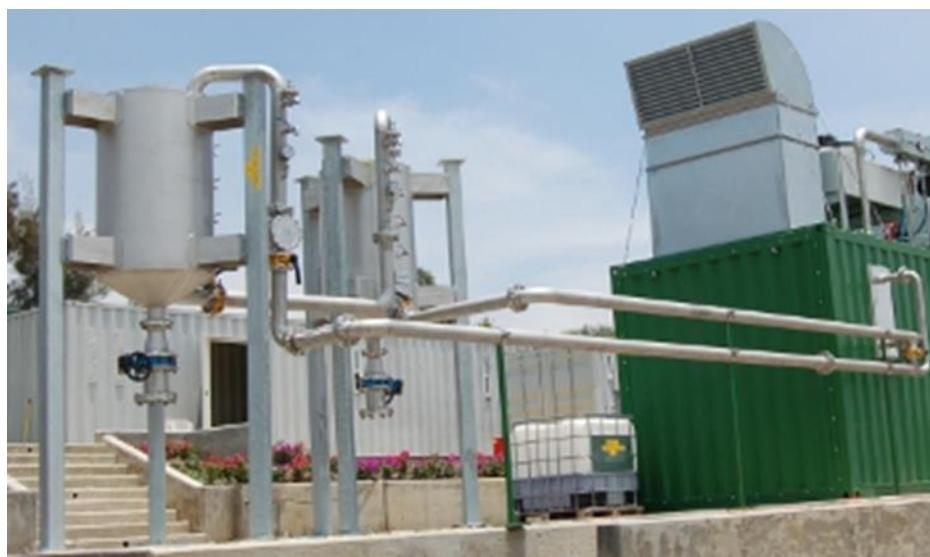
Slika 33. Spremnik i filter aktivnog ugljena
