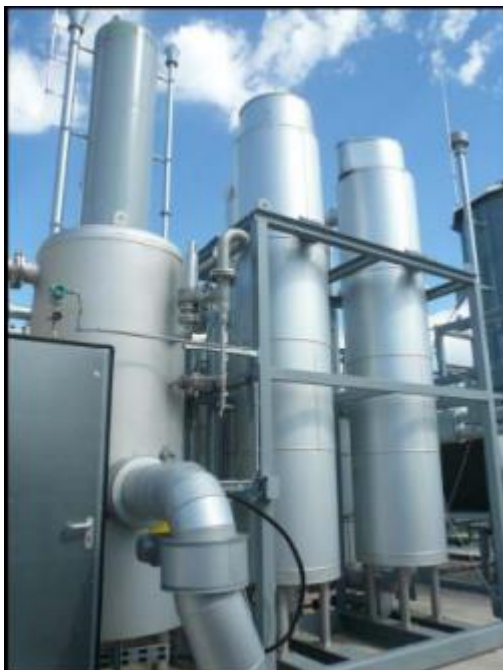
Slika 28. Rezervoar za sirovi bioplin (srijeda lijevo), x2 filter od aktivnog ugljena (sredina desno), spremnik za skladištenje biometana (otraga lijevo)
