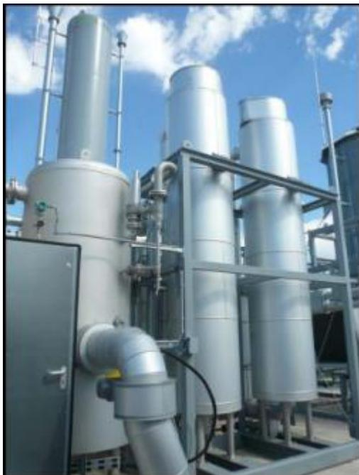
Slika 28. Rezervoar za sirovi bioplín (sprijeda lijevo), x2 filter od aktivnog ugljena (sredina desno), spremnik za skladištenje biometana (otraga lijevo)
