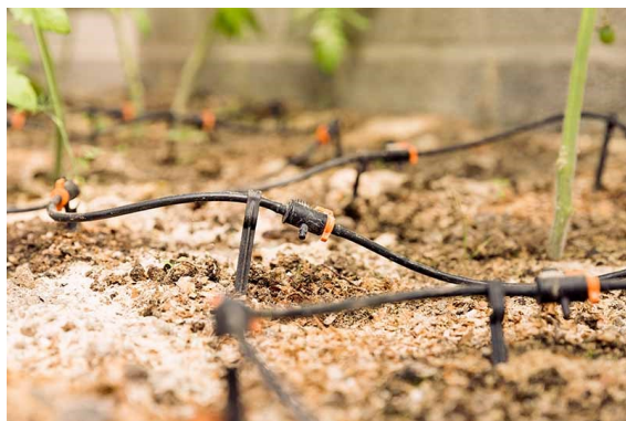
Slika 14. Cijevi izdignute iznad površine tla
