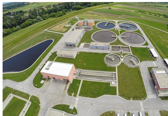
Sl. 29. Objekti za pročišćavanje otpadnih voda grada Karlovca i Duge rese
