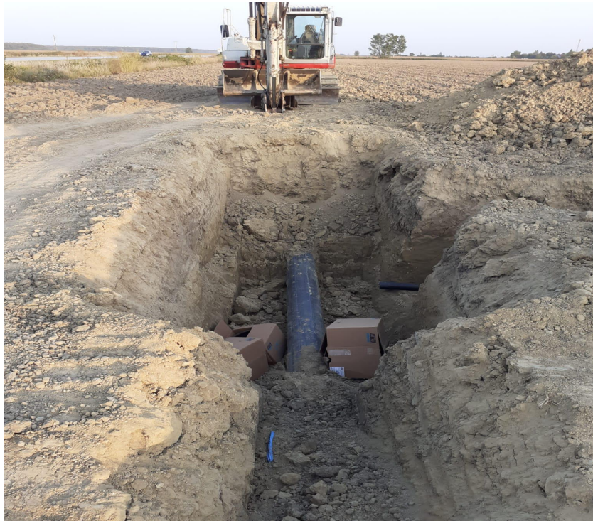
Slika 4. Ugradnja podzemnih dovodnih cijevi
