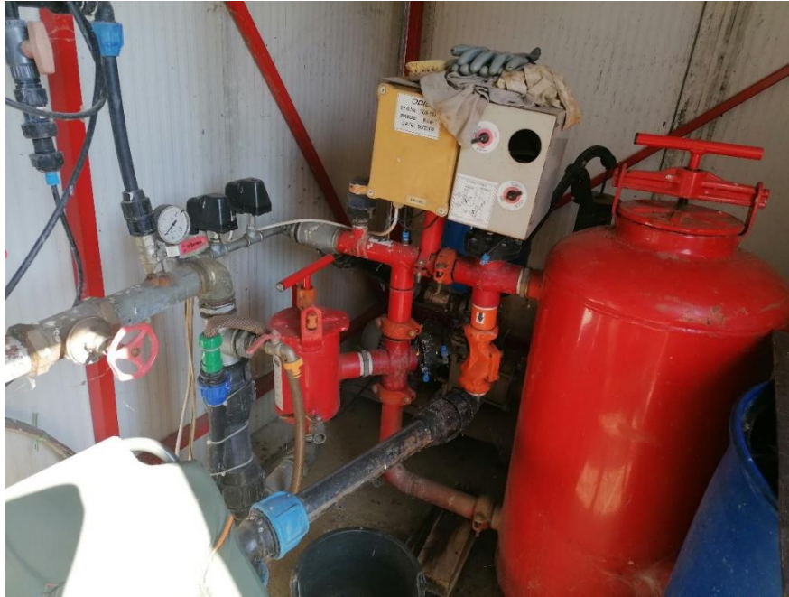
Slika 17. Sustav za navodnjavanje i fertirigaciju izvor: Škoro, 2020.
