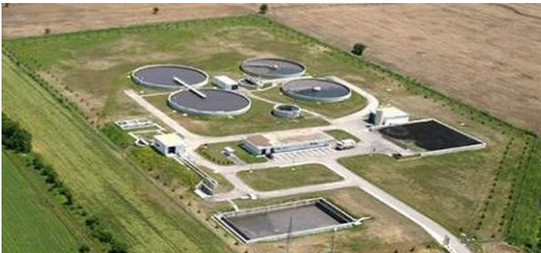
Slika 39. Industrijska zona Jošine – pročišćivači vode Izvor: https://www.elmap.hr/hr/reference
