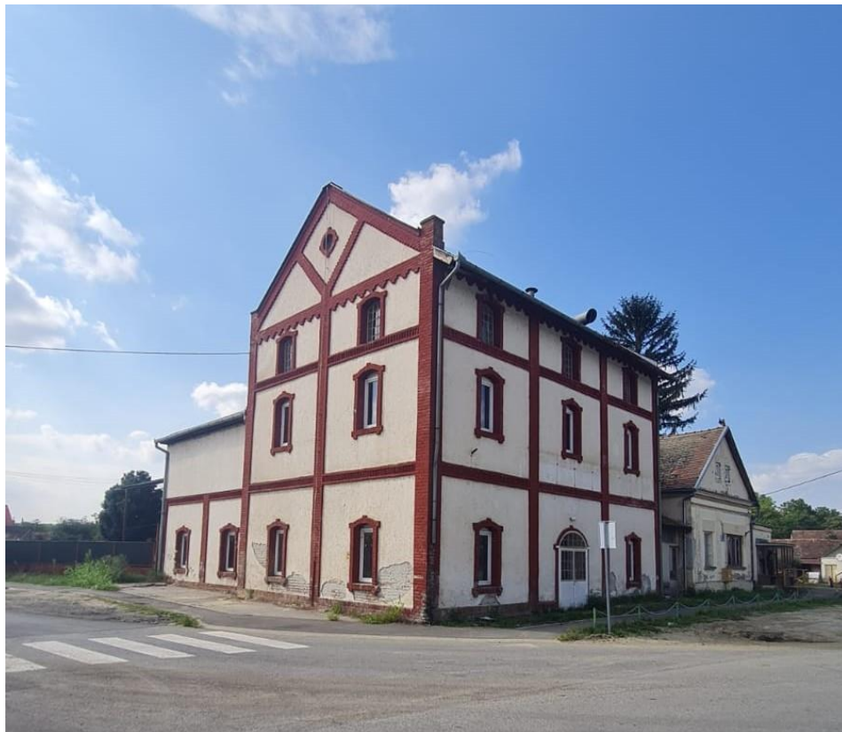
Slika 1. Zgrada nekadašnje kudjeljare u Črnkocima (Jonjić, A., 2022.)
