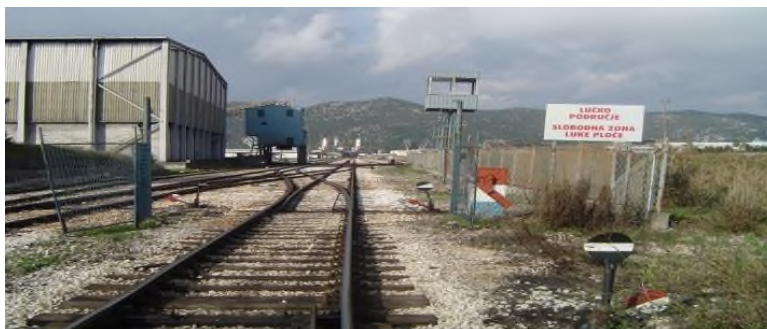
Slika 32. Industrijski kolosijek – Luka Ploče
