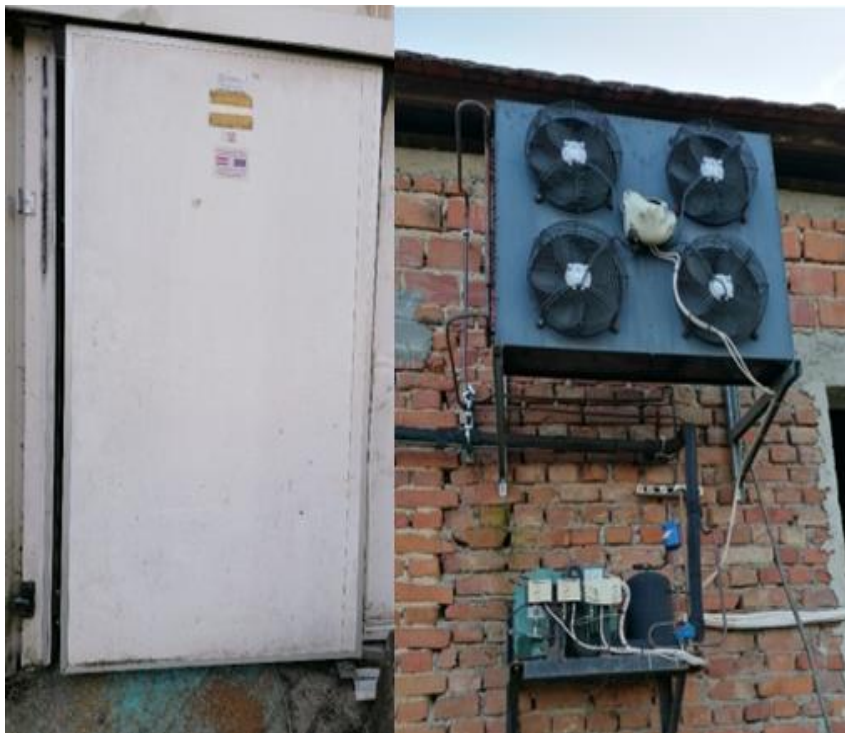
Slika 21. Hladnjača za skladištenje mrkve
