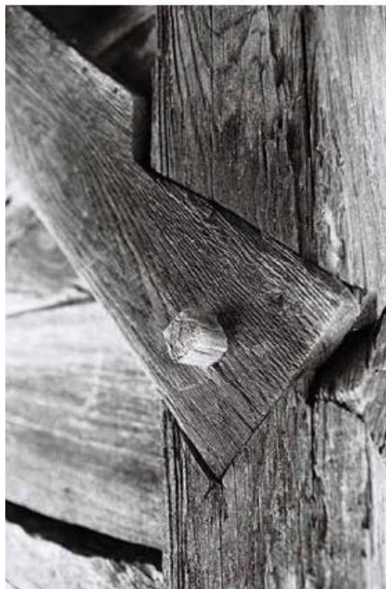
Slika 12. Spojnice od elemenata drva, bez metalnih spojeva i čavli Izvor: Živković, 2013.
