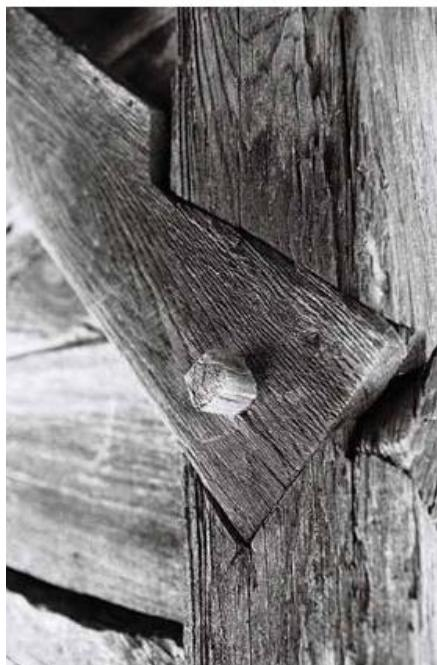
Slika 12. Spojnice od elemenata drva, bez metalnih spojeva i čavli
