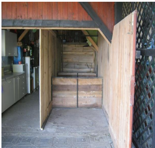
Slika 3. Unutarnji dio objekta
