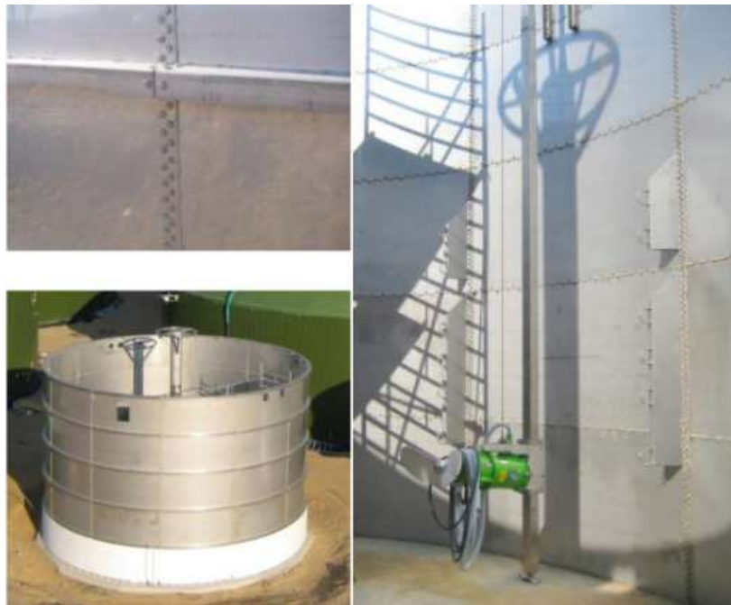
Slika 28. Spremnici od nehrđajućeg čelika za skladištenje gnojnice i fermentaciju bioplina (Izvor: www.worldstainless.org )
