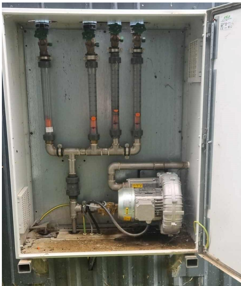
Slika 15. Desumporizator
