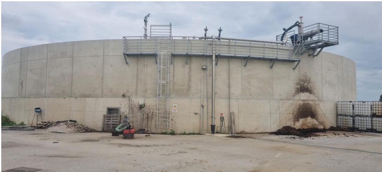
Slika 11. Skladište digestata, “laguna”
