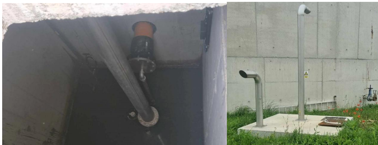
Slika 17. Kondenzacijska šahta
