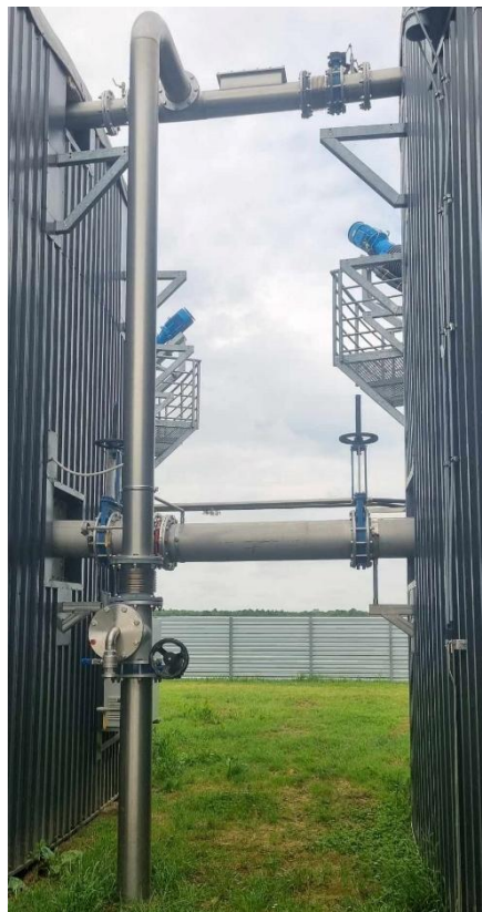
Slika 14. Preljevna cijev
