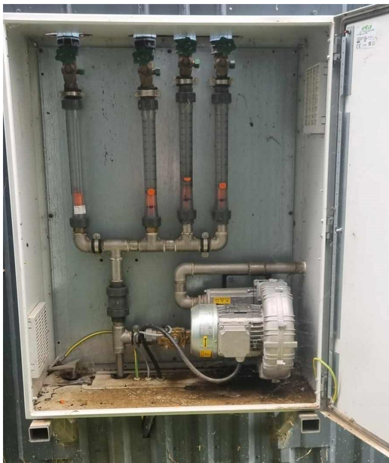
Slika 15. Desumporizator
