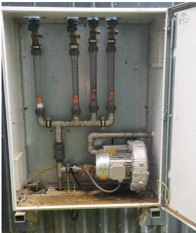
Slika 15. Desumporizator
