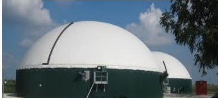
Slika 2. Primjer fermentora
