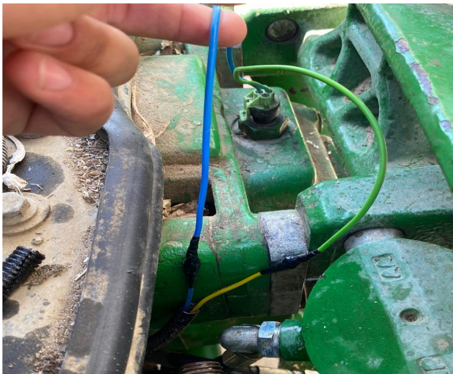
Slika 9. Oštećenost električne instalacije priključnog vratila
