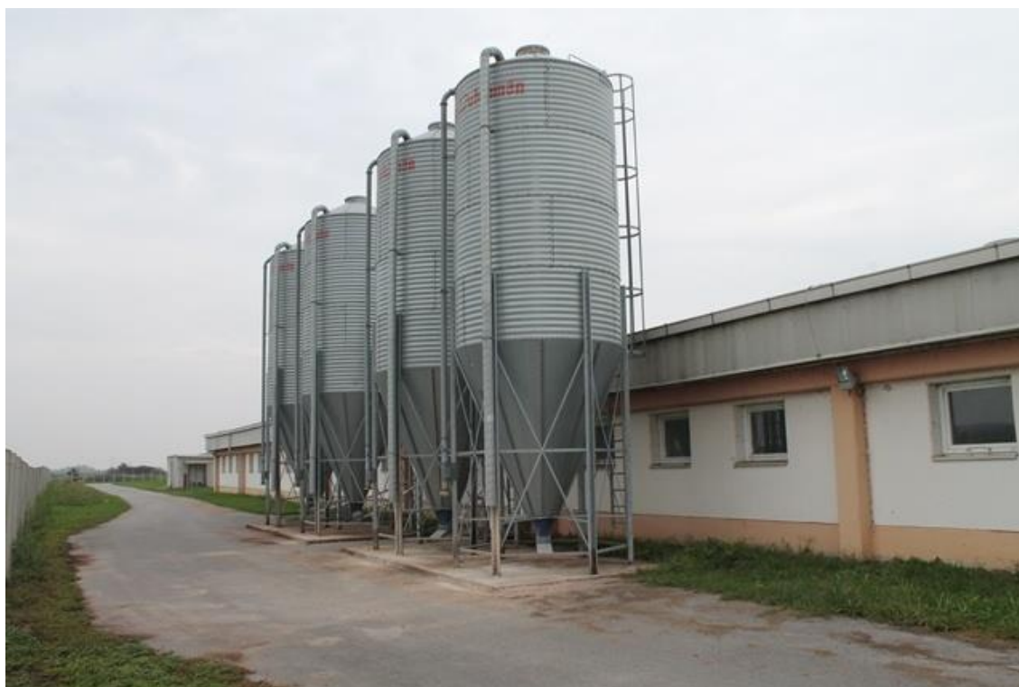
Slika 1. Silosi za hranu ( T.Svrtan )
