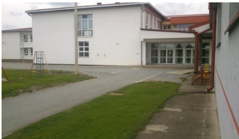
Slika 8. Zgrada škole - Asfaltirani put i betonirani prilaz u objekt; izvor: Tomislav Grgić, 2014
