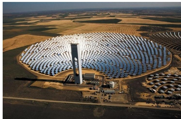
*Slika 7. : STE sa tornjem u Španjolskoj snage 11 MW*
