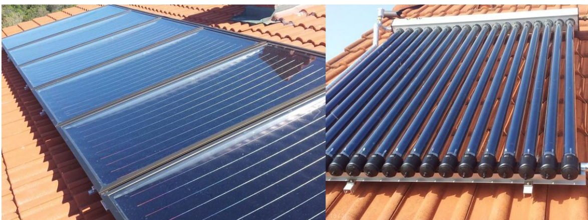
Slika 4. : Pločasti i vakuumski solarni kolektor
