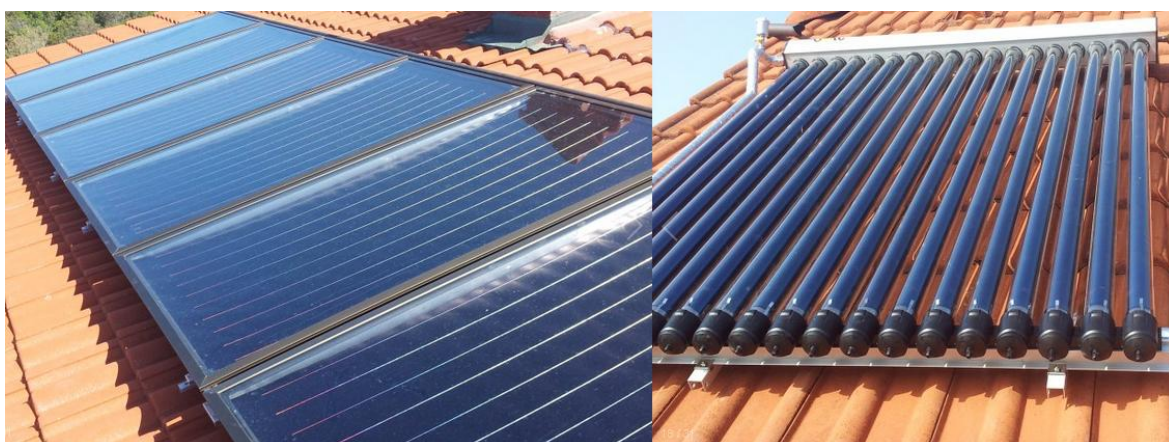
Slika 4. : Pločasti i vakuumski solarni kolektor
