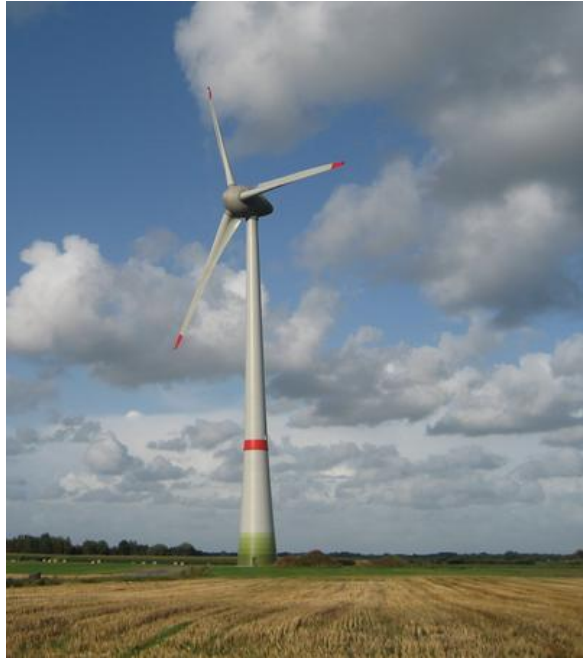
Slika 10. : Primjer VE s horizontalnom osovinom snage 7.5 MW, Belgija
