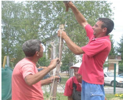
Slika br. 6. Postavljanje armature na PRZ, 06. 5. 2011.
