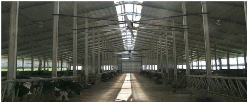
Slika 4. Ventilatori malih brzina i velikih protoka
