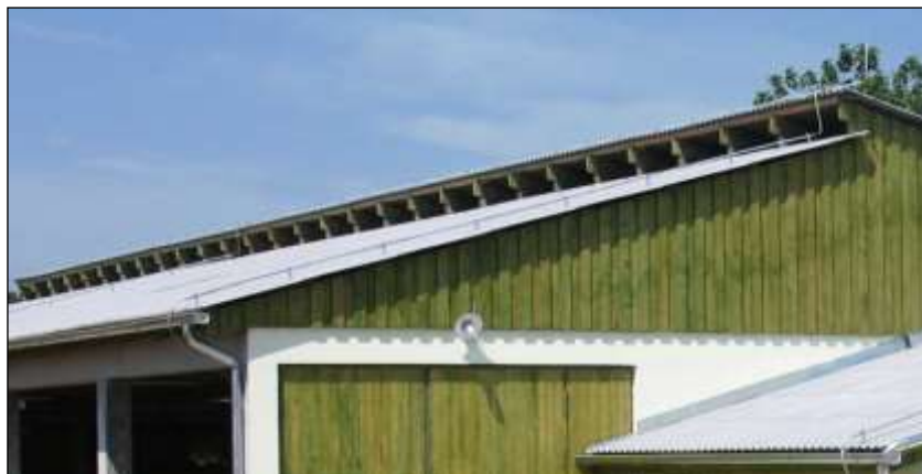
Slika 6. Krovni otvor za ventilaciju (Izvor: www.og-corp.hr/ )
