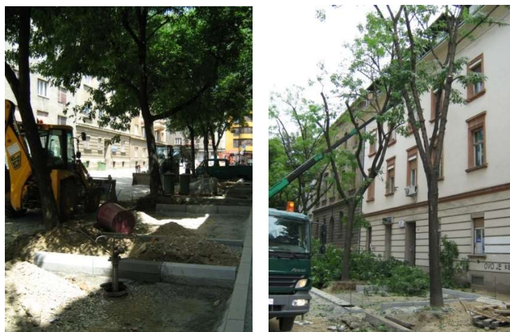
Slika 26. i 27.: Zahvati na drveću zbog rekonstrukcije cijele ulice
