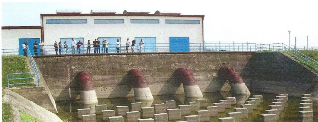
CS Dvor - nizvodno (nakon obnove)
