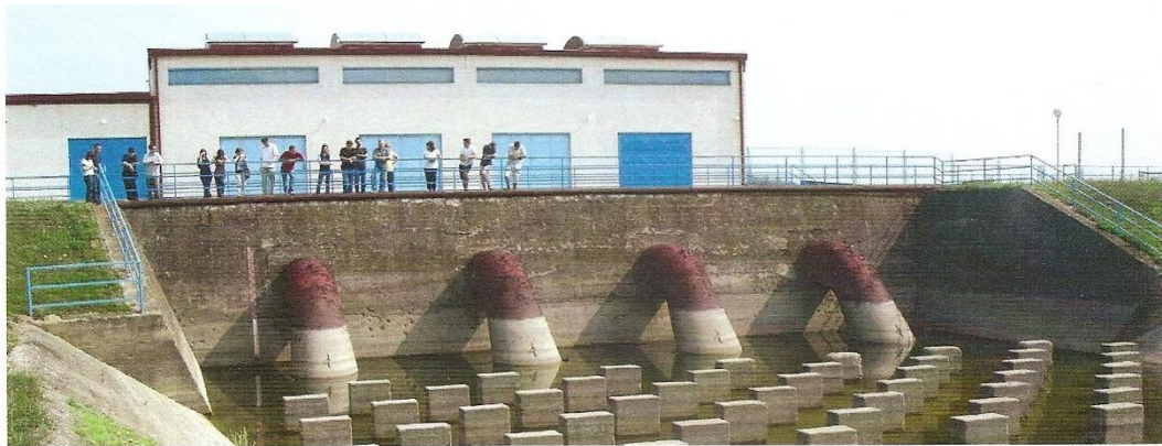
CS Dvor - nizvodno (nakon obnove)
