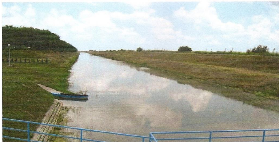
CS Dvor - dovodni kanal
