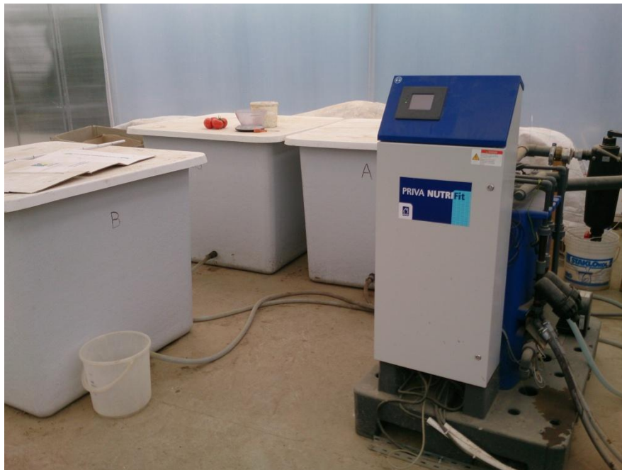
Slika 5. Kompjuterska jedinica za navodnjavanje (foto original)
